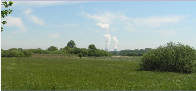
Foto: Nicht weit vom Ried dampfen die Kühltürme des AKW Gundremmingen.
